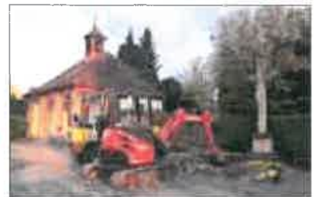
Sanierungsarbeiten im Alten Friedhof
