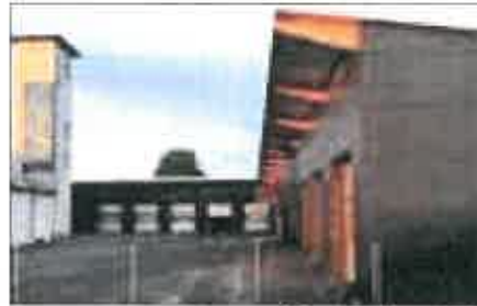
Neuer Gemeindebauhof September 2017
