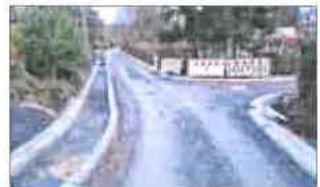
Straßenbau an der Roßsteige
