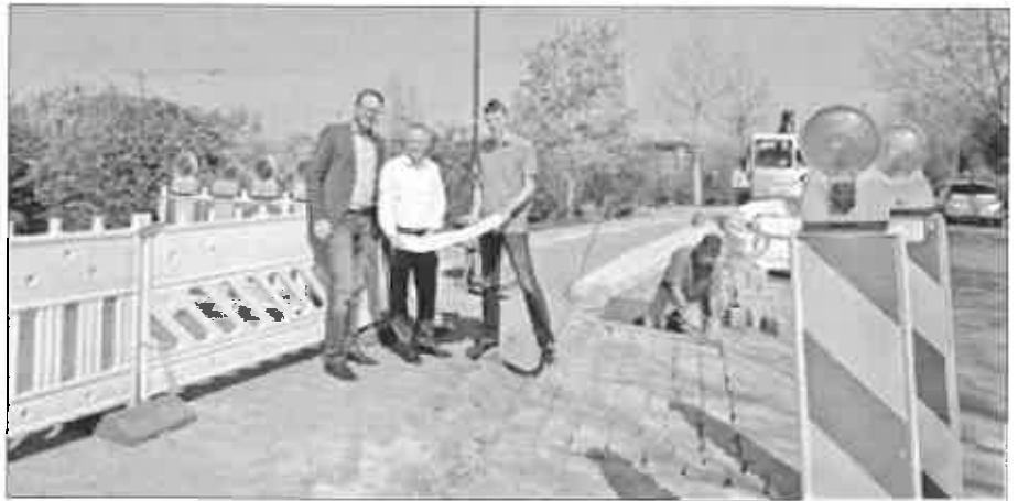
Überzeugen sich vom Baufortschritt: Geschäftsleiter Markus Meyer, Bürgermeister Stefan Wolfshörndl, Dipl.-Ing. Nils Haag, Bauamt
